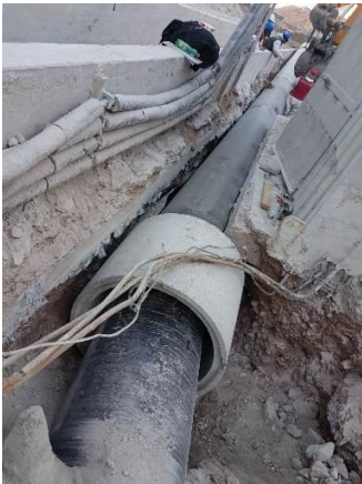
Figura 3-12: Instalación tubería en Terreno.
