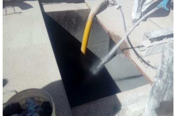
Remoción de Relaves con Hidrojet y Supersucker
