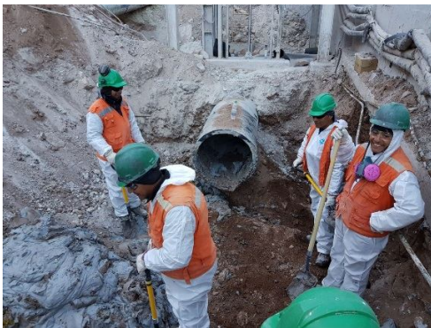
Figura 3-9: Corte y limpieza tubería de Lamas, aguas debajo de la Compuerta CL.
