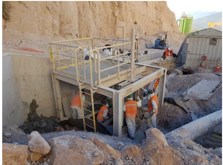
Figura 3-6: Término limpieza sumidero (compuertas).
