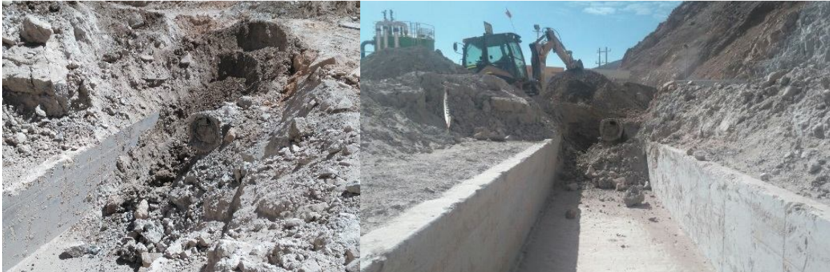
Figura 3-3: Remoción del material de obstrucción en canal de hormigón.
