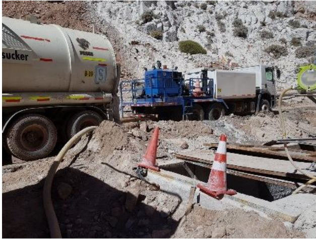
Figura 3-18: Limpieza del Desarenador.
