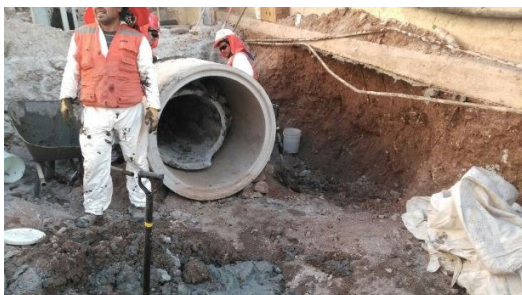
Figura 3-10: Ejecución del Inserto, transición a 800[mm].
