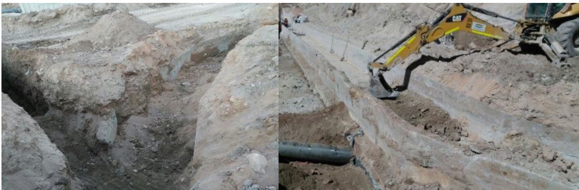
Figura 3-4: Detalle retiro de material sección final canal de hormigón.
