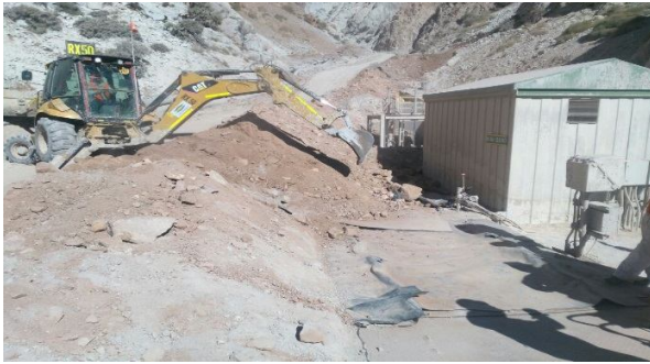
Figura 3-14: Tareas de limpieza exterior del desarenador.
