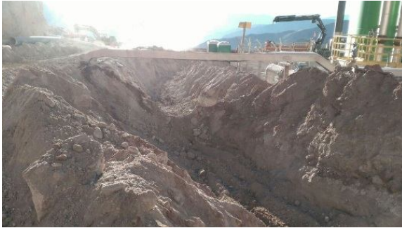
Figura 3-5: Conformación canal de salida (desde el canal de hormigón).
