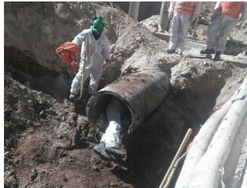
Figura 3-9: Corte y limpieza tubería de Lamas, aguas debajo de la Compuerta CL.
