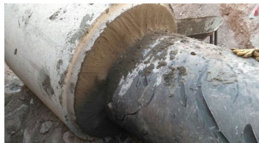
Figura 3-10: Ejecución del Inserto, transición a 800[mm].
